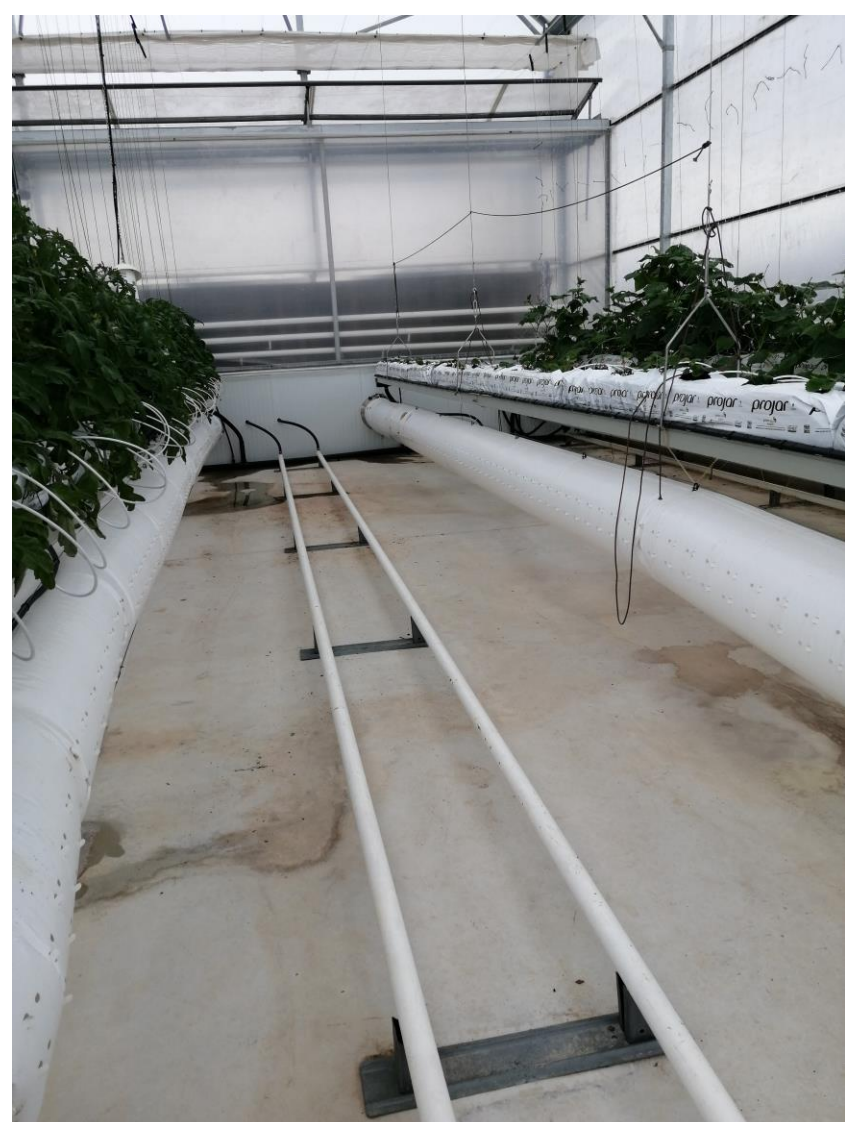
Figura 1. Conexión del sistema de distribución de aire con la cámara de enfriamiento y sistema de distribución del aire
